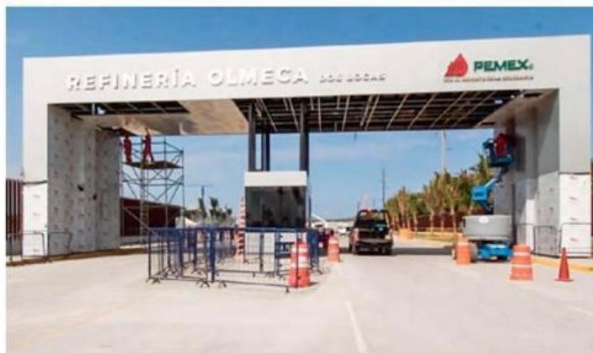
CONSTRUCCIÓN. El presidente Andrés Manuel López Obrador ha asegurado que la refinería de Dos Bocas, Tabasco, se inaugurará el 2 de julio próximo.
