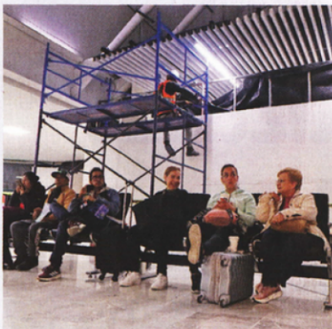
Falta de infraestructura en el Aeropuerto Internacional de la Ciudad de México.
