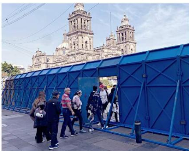
■ Personas que recorren el Centro Histórico tuvieron que pasar por los filtros instalados en esquinas de la plancha del Zócalo.
