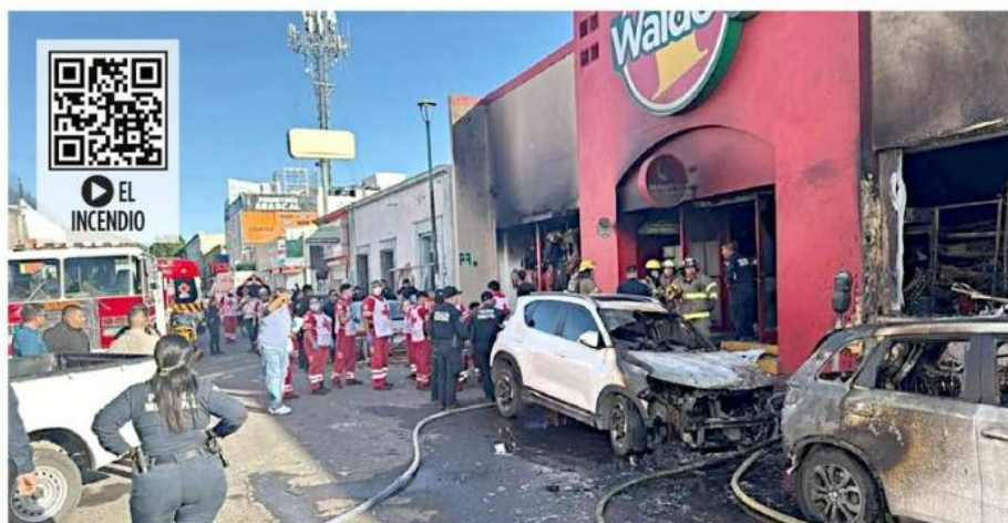
El cuerpo de bomberos de Hermosillo y elementos de Protección Civil realizaron inspecciones y levantamiento de escombros en el inmueble tras su explosión.
