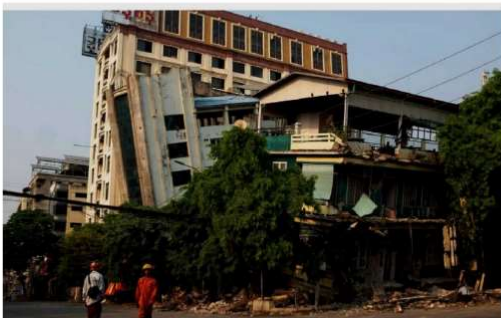
Rescatistas caminan frente a un edificio dañado por el terremoto en Mandalay, Myanmar
