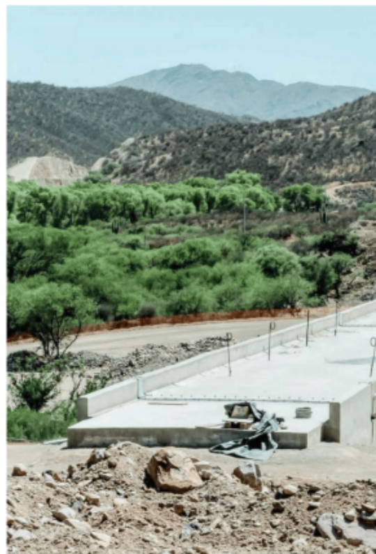
Obra del puente núm. 12 sobre el río Cocóspera en la Reserva Natural Rancho el Aribabi
