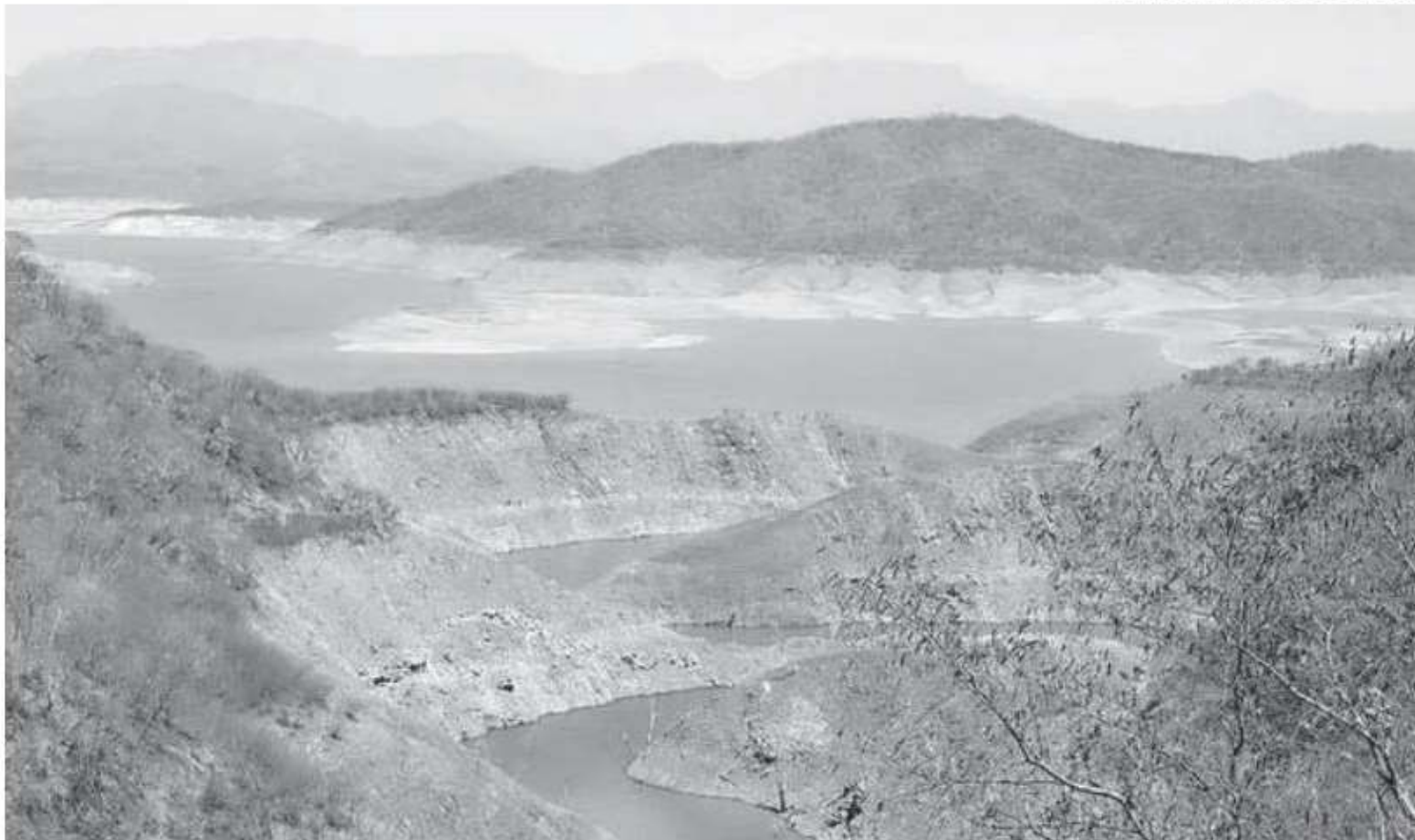
La presa José López Portillo, ubicada en el municipio de Cosalá, Sinaloa
