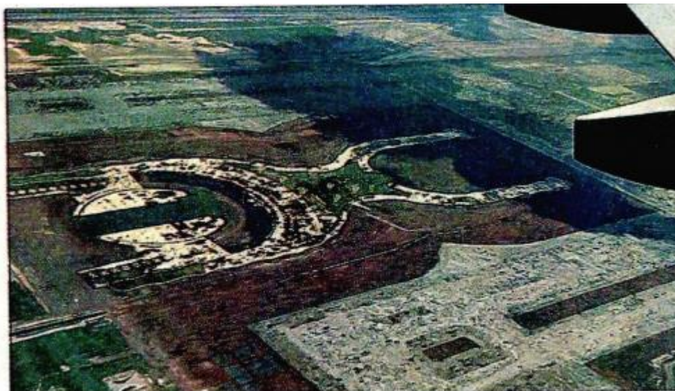
▲ En el proyecto del aeropuerto de Texcoco, ante el obvio hundimiento del terreno, ingeniosamente los empresarios de siempre "ofrecieron" los trabajos de nivelación. Foto La Jornada
