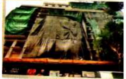
En obra: Prosperidad 4, Escandón II.
