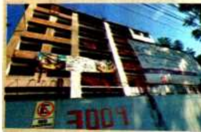
En obra: Miramontes 3004, Coapa, Girasoles II.
