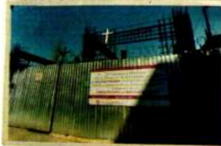
En obra: Gral. Manuel Rincón 142, General Anaya.
