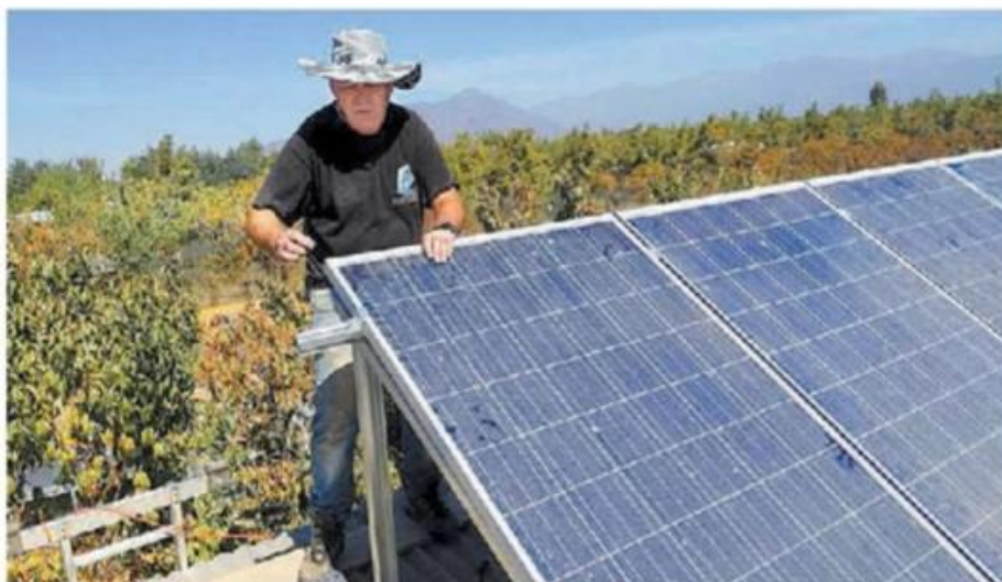
Instalación de techos solares. ESPECIAL
