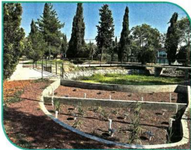
■ Humedal construido en la Segunda Sección del Bosque.
