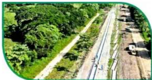
Los trabajos en el Istmo registran rezagos considerables.
