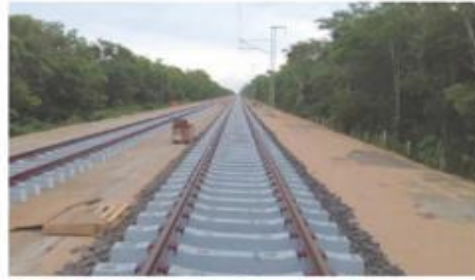
ASPECTOS del Tramo 5 sur del Tren Maya, obra que une a los destinos turísticos de Playa de Carmen y Tulum.
