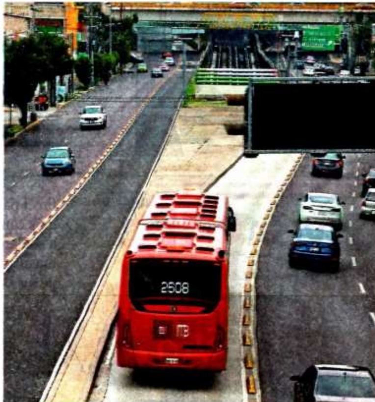
En la construcción del corredor vial para el transporte público, detectan pagos en exceso y otras irregularidades que deben ser aclarados por el gobierno capitalino /IGNACIO HURTIZL
