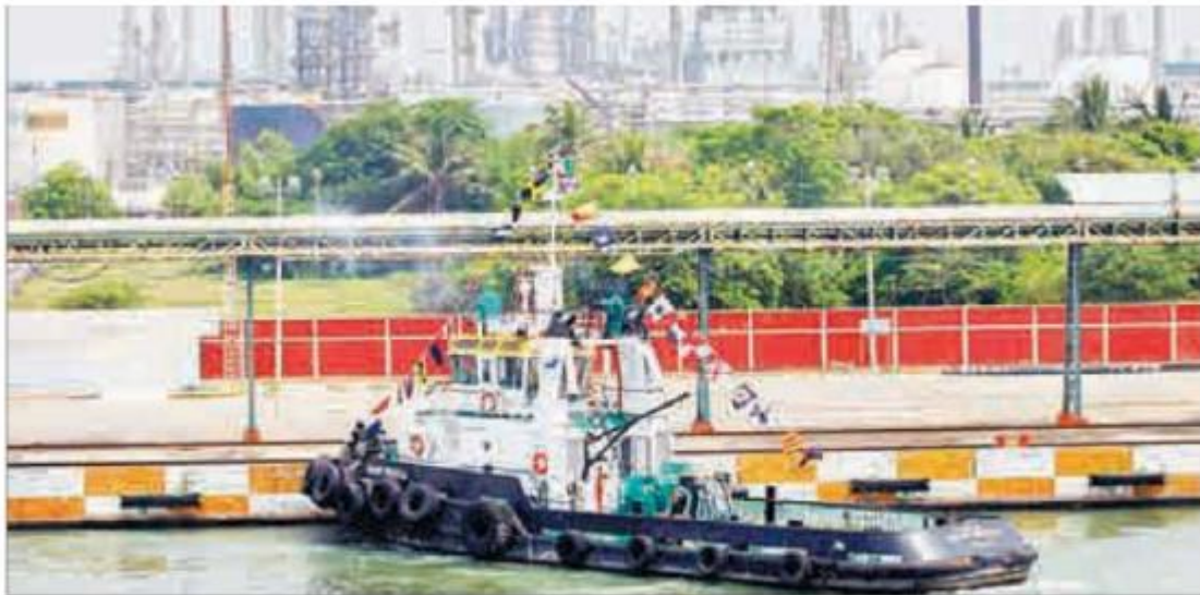
▲ Detalle de la refinería Francisco I. Madero, en Tamaulipas, que elevó su producción a casi 70 por ciento de su capacidad instalada. Foto Marco Peláez
