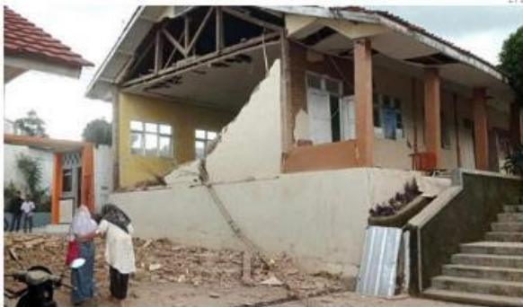
Edificio destrozado en Cianjur, epicentro del terremoto, y localidad a tan solo 75 kilómetros de Yakarta.
