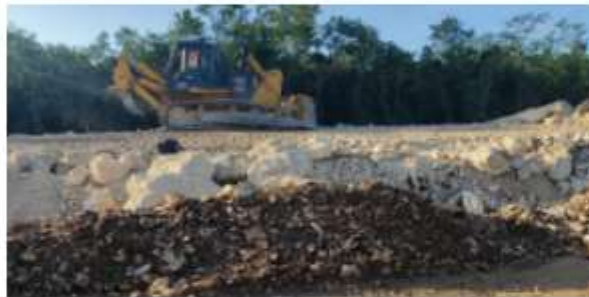
AVANCES el tramo 5 norte de la obra, el pasado domingo.
