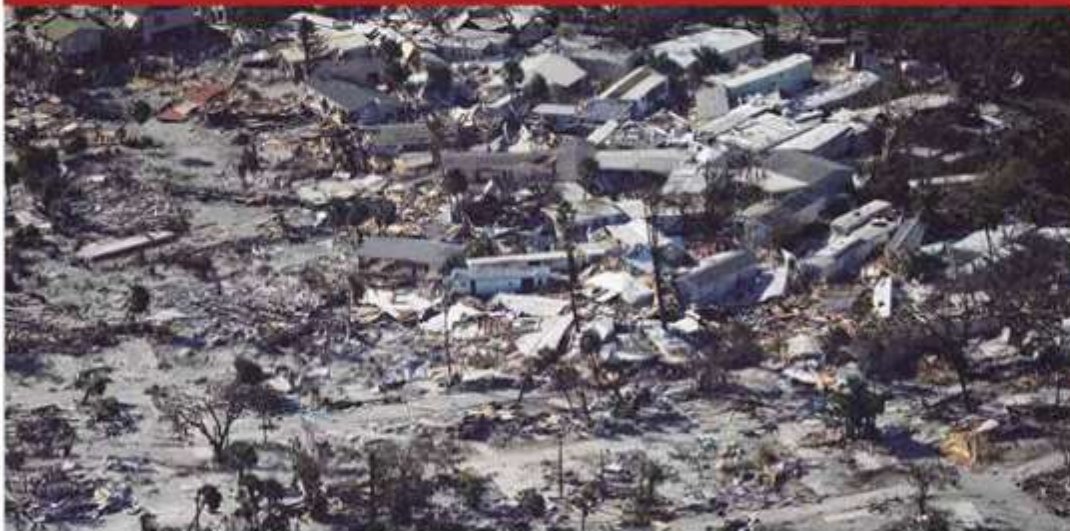
El pesco de Fort Myers, Florida, quedó destruido tras el paso del huracán Ian. En primeros reportes de daños el número de muertes asciende a 54 personas y los daños todavía se consideran incalculables, porque hay al menos 10 mil viviendas destruidas y la mayoría sin cobertura para este tipo de afectaciones. (Foto: Cortesía de San Diego Union) » Pág. 19
