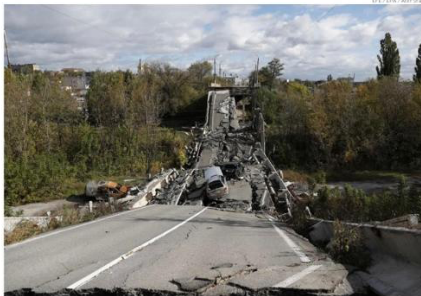
Vista de un puente derrumbado en Kupiansk, región de Járkiv, el lunes 3 de octubre de 2022.
