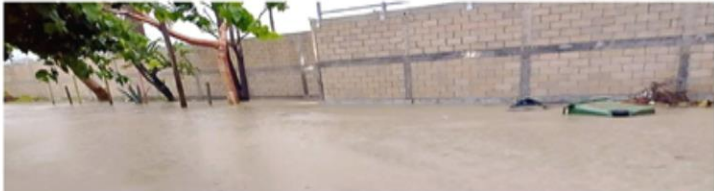
Pobladores aseguran que el terreno aplanado, los nuevos caminos y la barda perimetral de la refinería, han bloqueado el paso del agua de lluvia y su absorción en los manglares.
