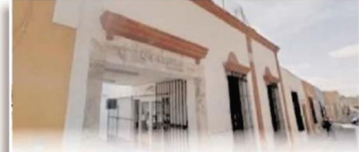
EDIFICIO DE DEPARTAMENTOS CALLE 57 #41, CENTRO HISTÓRICO
