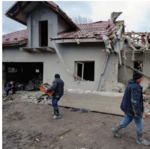
RESIDENTES DE LEÓPOLIS recogen escombros en uno de los edificios alcanzados por un misil, ayer.
