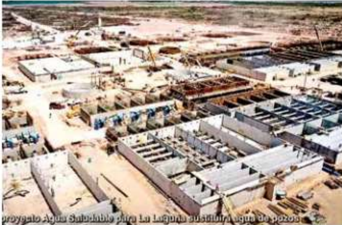
proyecto Agua Saludable para La Laguna sustituirá agua de pozos
