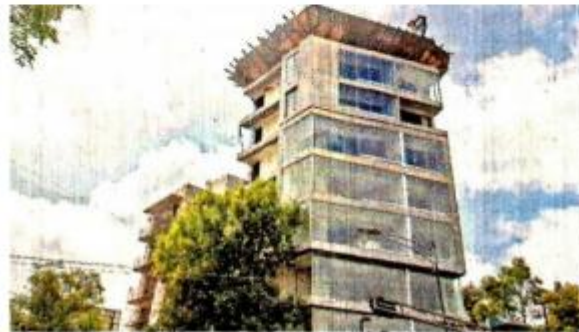
■ La PAOT derribó en 2020 siete pisos construidos ilegalmente en el edificio de Baja California 370.
