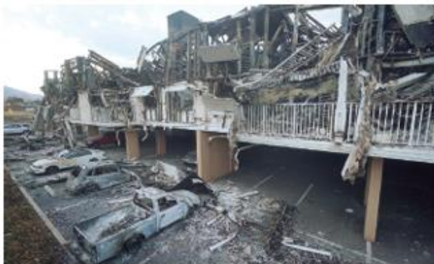
UN EDIFICIO residencial y vehículos dañados tras el incendio en Lahaina, ayer.
