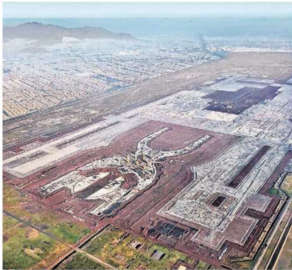
Vista aérea de la inacabada construcción. CUARTOSCURO
