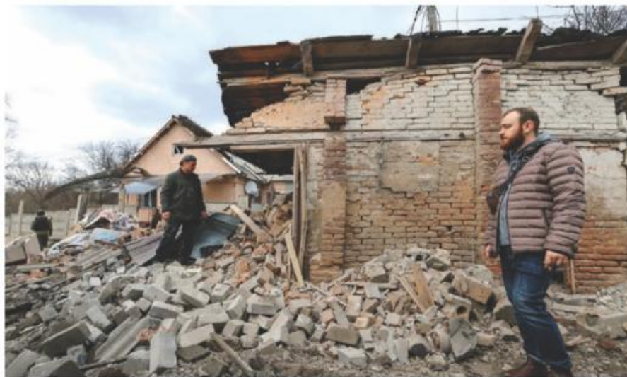
CIUDADANOS EVALÚAN LOS DAÑOS en inmuebles alcanzados por los ataques rusos en Donbás, ayer.
