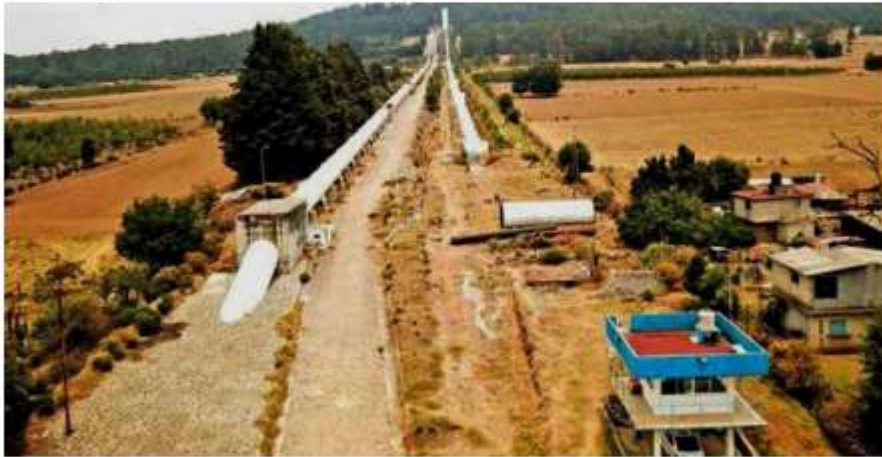
Las dos líneas de acueducto del Sistema Cutzamala que conducen el agua potable desde Los Berros hacia el Valle de México.
