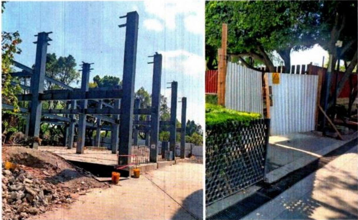
El edificio J de la Cámara de Diputados, ubicado a un costado de la puerta 4, albergará oficinas para el personal y un espacio para los talleres gráficos del recinto.
