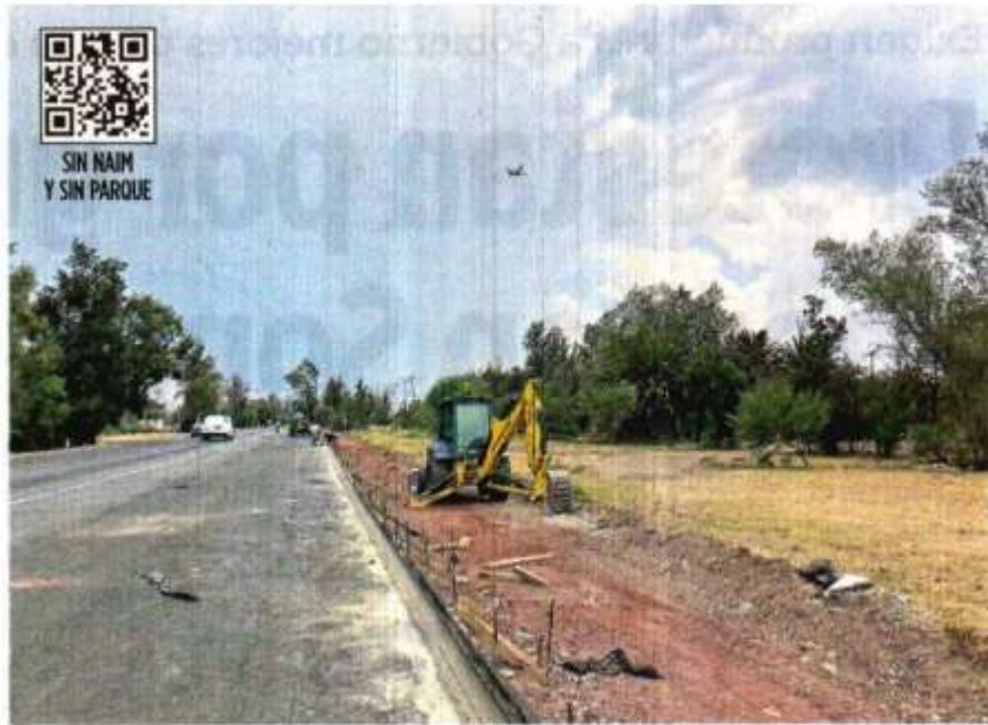
LENTO AVANCE. Trabajadores del Parque Ecológico Lago de Texcoco refieren que la primera etapa de la obra aún no está lista; apenas, dicen, construyen estacionamientos y ciclovías.
