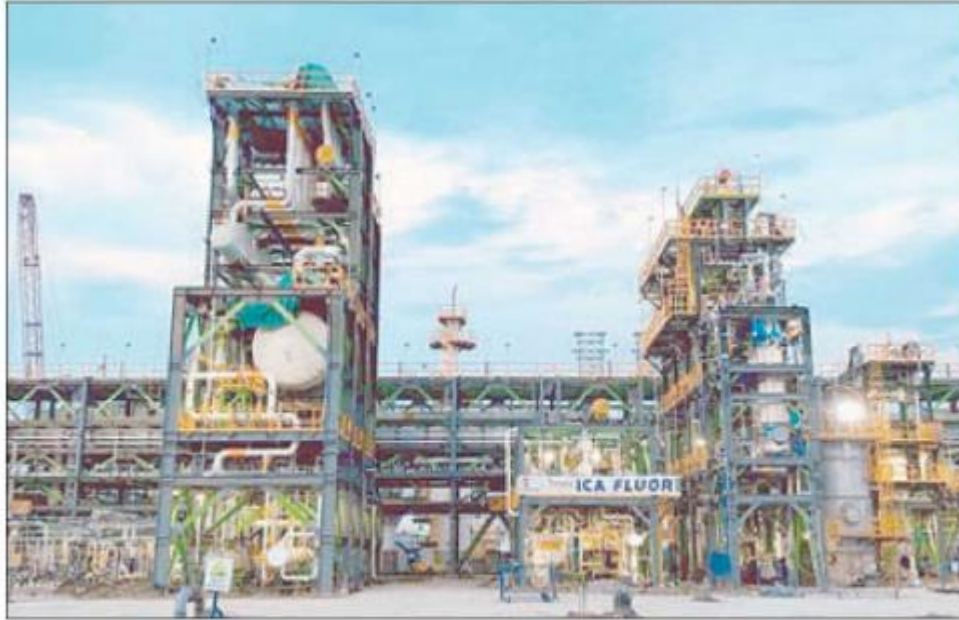
Planta química "Isomerizadora de pentanos" de la Refinería Olmeca-Dos Bocas, en Tabasco. Foto tomada del Twitter de la Refinería
