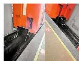
4. Los cables se pegan a la barra electrificada y hay un corto circuito.
