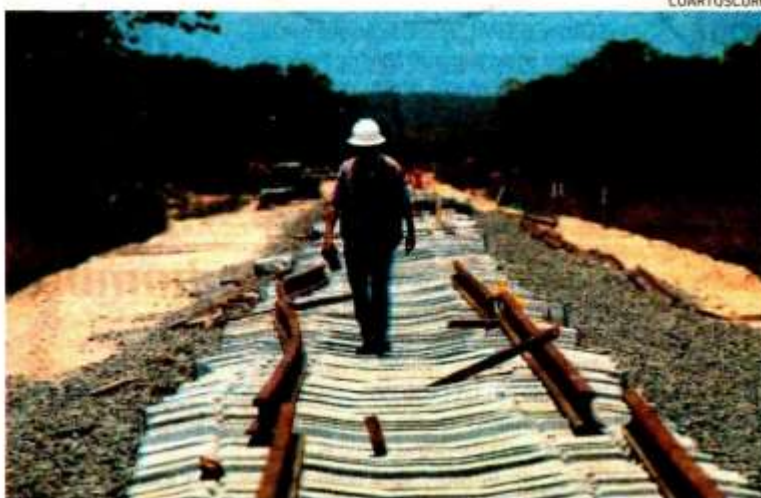
La obra abarca a cinco estados del sur-sureste de México
