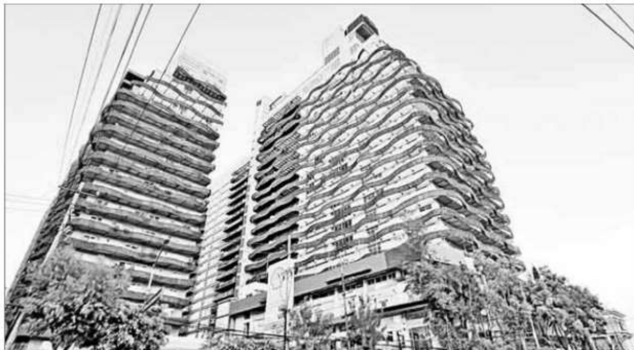
▲ Vista del megacomplejo habitacional City Towers, el cual fue construido con irregularidades al amparo de autoridades de la entonces delegación y hoy alcaldía Benito Juárez. Foto José Núñez
