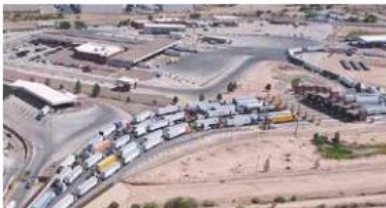
SE MANTIENE CERRADA. Aduana Puente de las Américas.
