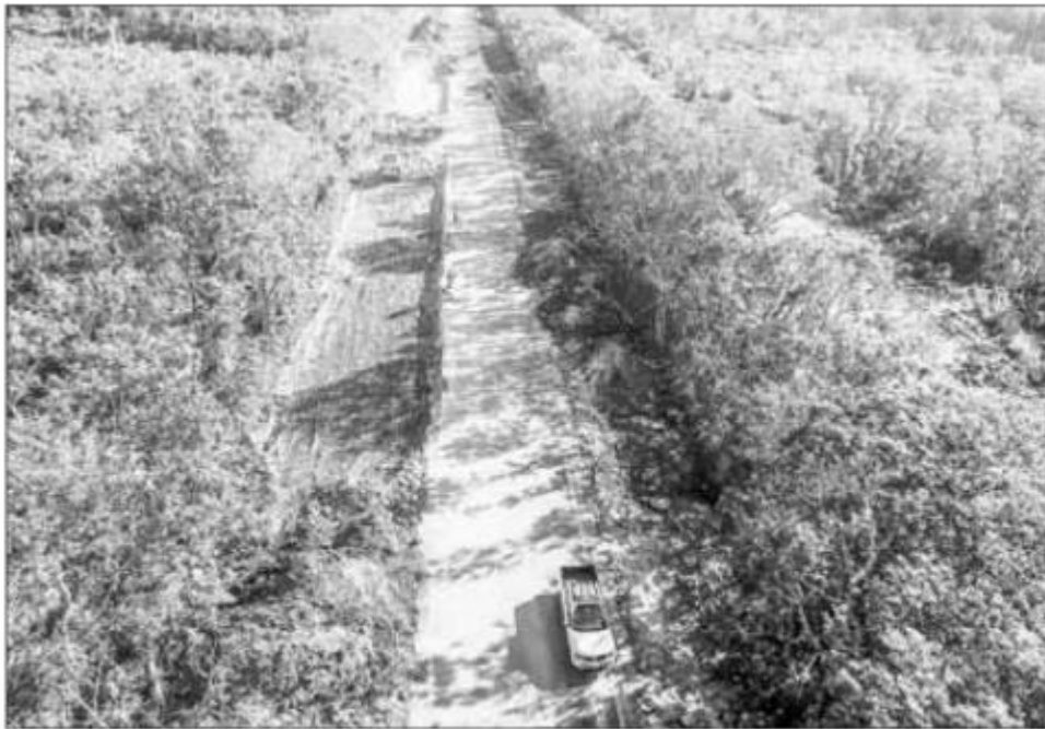
Las obras estuvieron detenidas por tres meses, lo cual causó pérdidas económicas a la hacienda pública, dijo el Presidente. Foto Cuartoscuro
