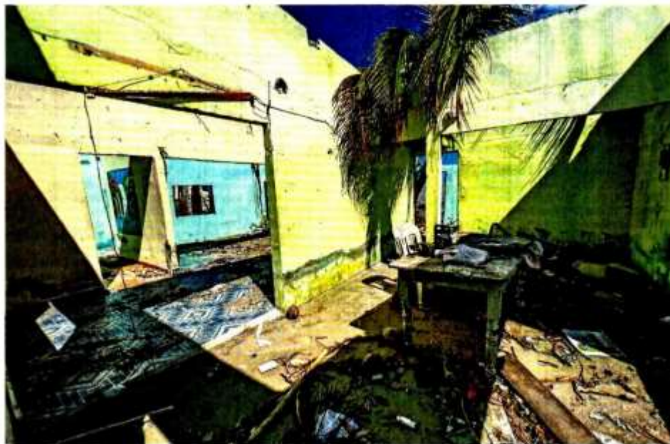
El avance del mar destruyó calles, caminos, los postes de energía y hasta las palmeras.
