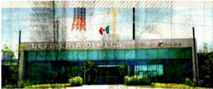
En la revisión a la Cuenta Pública 2020 se detectaron 59.2 millones de pesos en pagos indebidos a trabajadores en la obra de la refinería de Dos Bocas, Tabasco.
