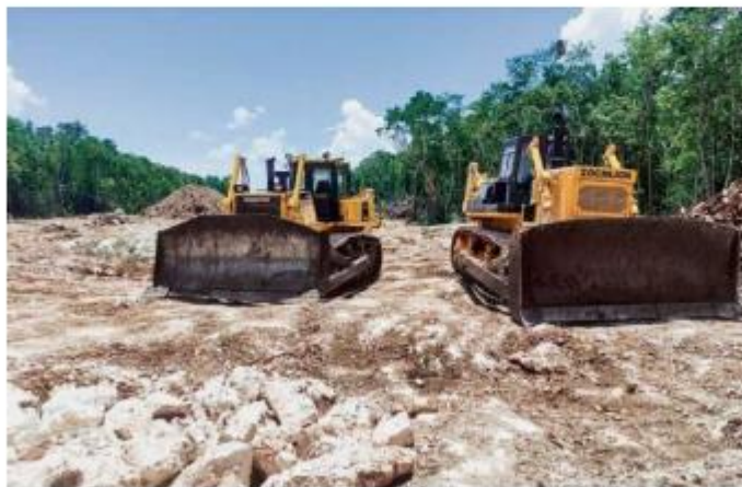
PROYECTO. En el Tramo 5 del Tren Maya, ya se observan a trabajadores; esta zona ha sido una de las más polémicas durante la construcción de dicha obra.
