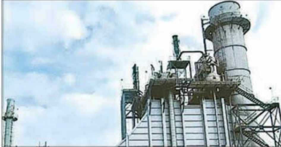
El Centro Nacional de Control de Energía desconectó ayer la planta de ciclo combinado
