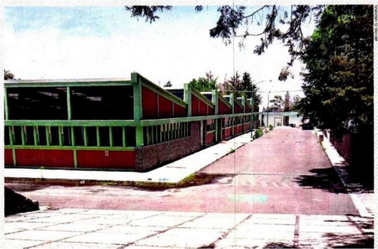
Con un presupuesto de 10 mil millones de pesos, Proyecto Chapultepec es la obra más ambiciosa de la administración en material cultural. En la imagen, las obras de Bodega Nacional de Arte y la Cineteca.
