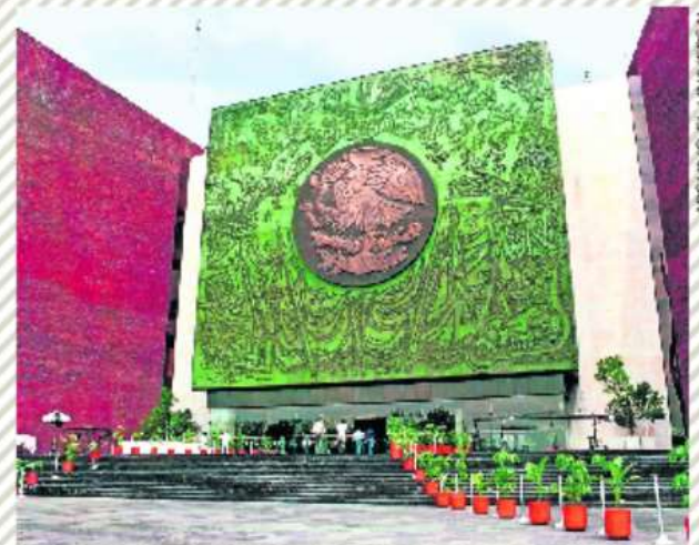
La tubería bajo el recinto de San Lázaro tiene alrededor de 50 años de antigüedad, indica Sacmex.
