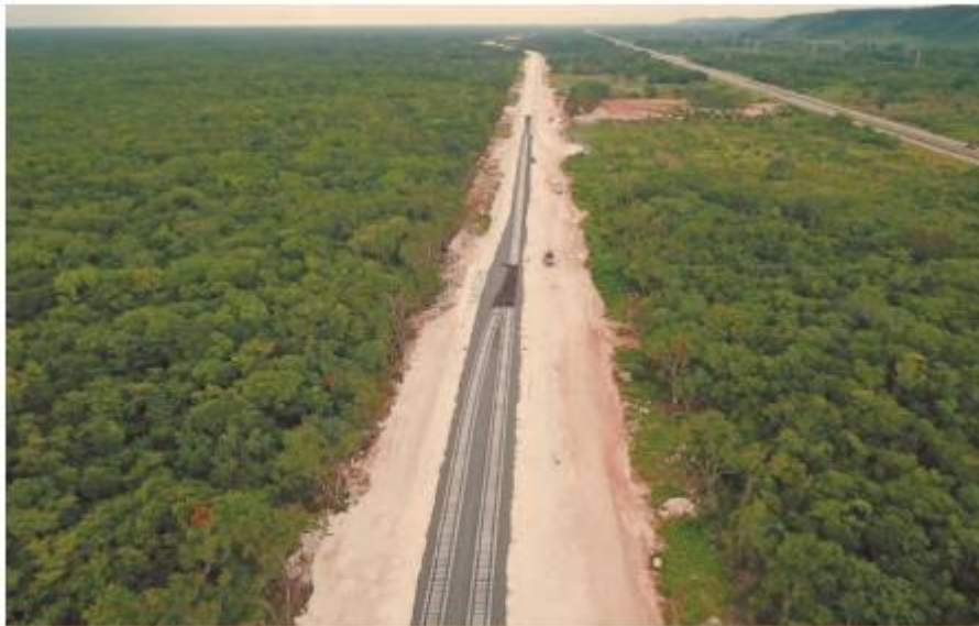
El Tren Maya está programado para ser terminado durante el 2023, cuando se ejercería más de la mitad del gasto para esta obra. FOTO: CUARTOSURIO
