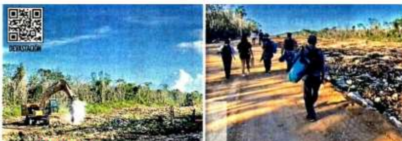
RECORREN TRABAJOS. Activistas recorrieron ayer el Tramo 5 del Tren Maya, a la altura del municipio de Solidaridad, en Quintana Roo, donde constataron el uso de maquinaria que, afirman, daña cenotes y cavernas.
