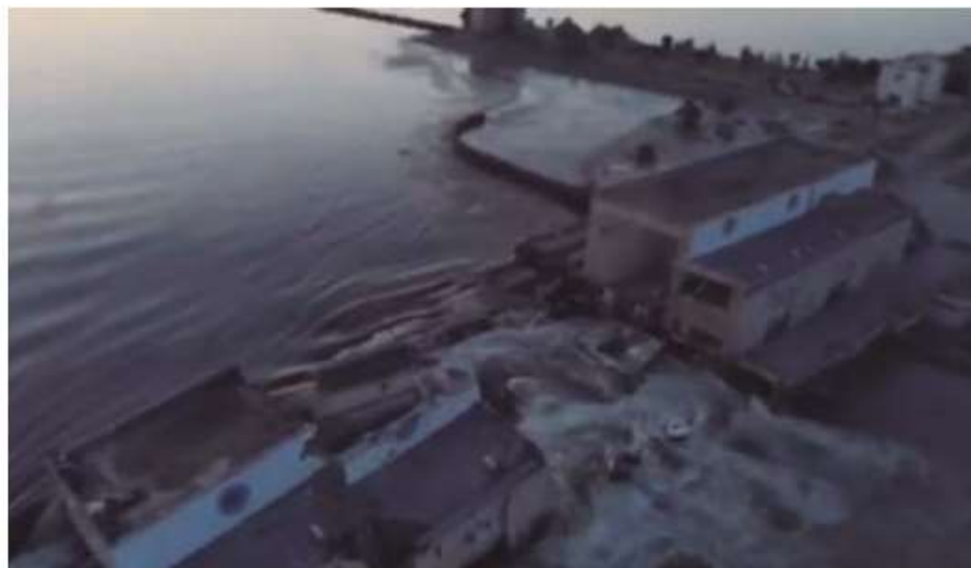
Daños. El muro de la presa de Kajovka, al sur de Ucrania, fue destruido.
