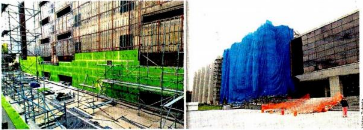
■ Trabajos de remodelación en las fachadas de los edificios C, G y B de la Cámara de Diputados, a cargo de Interiorismo Corp.
