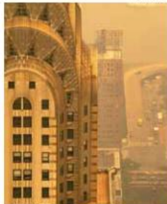
• EFECTO. Edificio de Chrysler estaba cubierto por la neblina.
