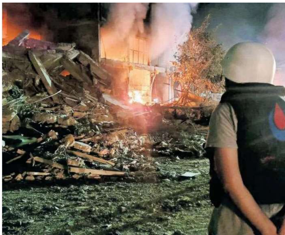
Una persona observa la destrucción de un edificio en territorio fronterizo de Líbano
