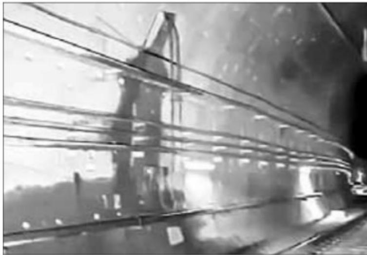
▲ Trabajos de perforación para erigir un inmueble de manera irregular en Benito Juárez atravesaron el túnel de la línea 12 del Metro entre las estaciones Eje Central y Parque de los Venados, lo que causó filtraciones de agua, lodo y material de construcción. Foto La Jornada
