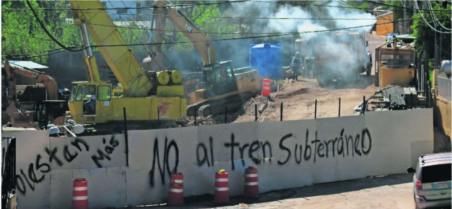
En la barda metálica de la lumbrera del tren en la colonia Buenos Aires se alcanzan a leer mensajes de protesta colocados por los vecinos. Las críticas son por la contaminación que generan los trabajos.
