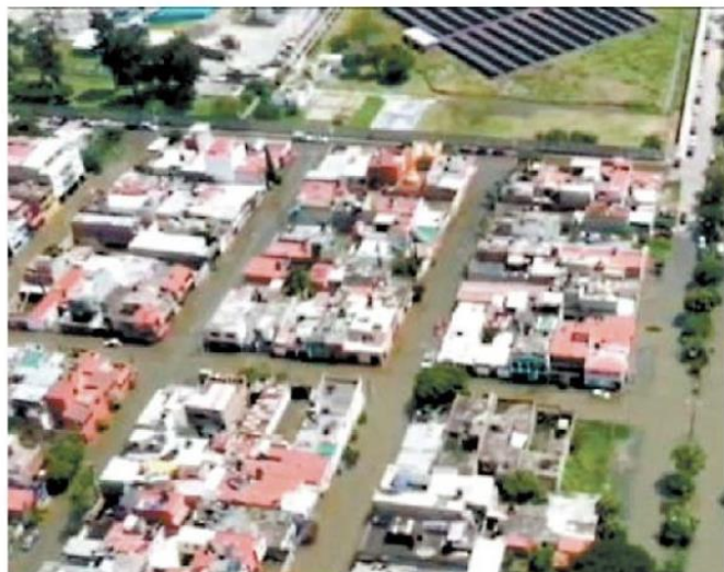
Desfogue ocasiona daños en 350 casas. ESPECIAL
